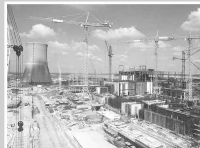
Staveniště HVB 1 v létě 1983
