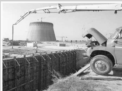
Výstavba chladičích věží a betonáž základové desky
